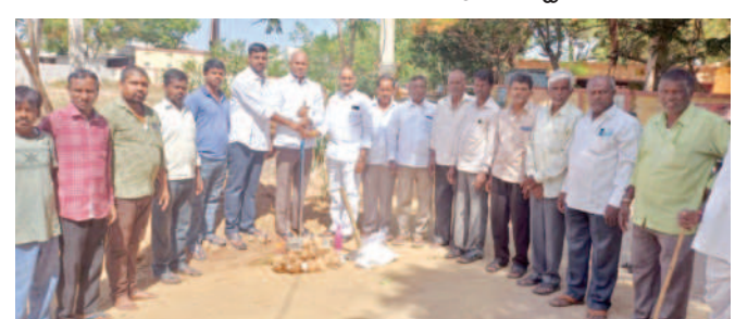
కేశవరంలో అందర్ గ్రౌండ్ డ్రైనేజీ నిర్మాణ పనులకు భూమి పూజ చేసిన మండల ఎంపిటిసీల సోం అధ్యక్షులు,గ్రామ ఎంపిటిసీ గోసే హన్మంతరెడ్డి, పాల్గొన్న నాయకులు, తదితరులు
